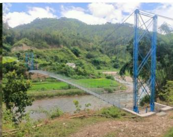
(भोलुङ्गे पुल निर्माण I)
