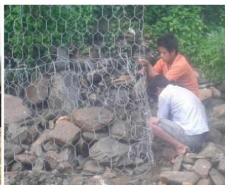
( नदी किनारमा तटबन्ध निर्माण I)
